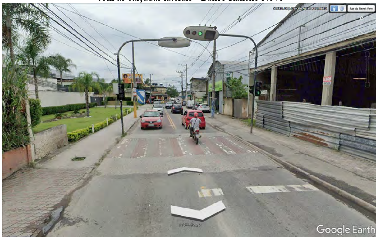
Figura 39 - Faixa elevada para travessia sem manutenção, sem piso tátil e sem contiguidade com as calçadas laterais - Bairro Rancho Novo
