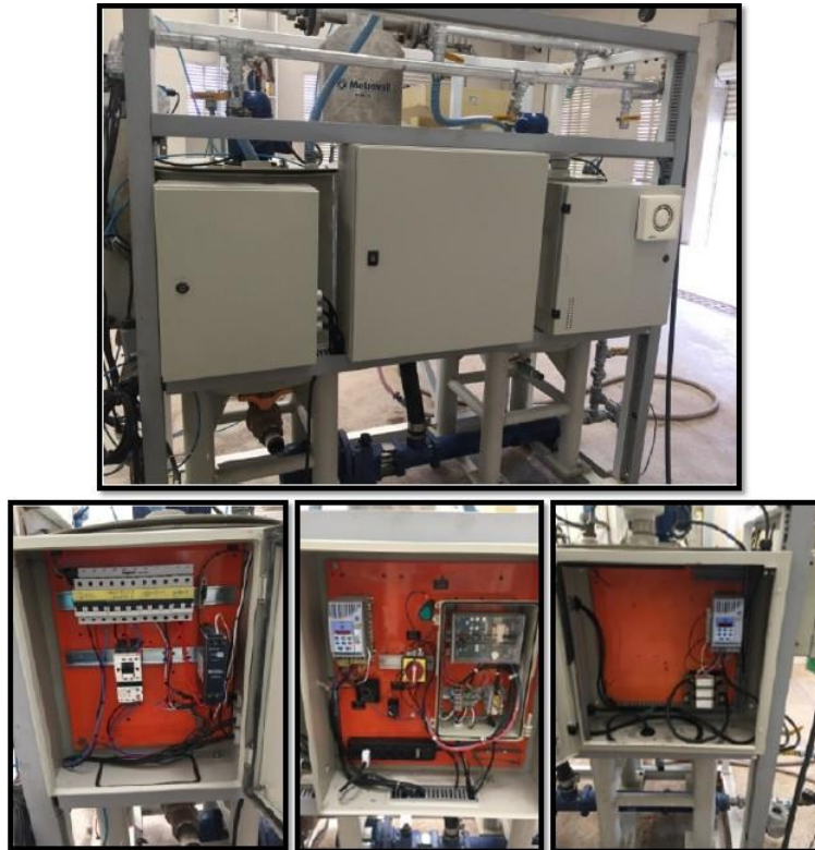
Figura 3.16: Quadros de comando e força da unidade experimental (acima) e seus interiores (abaixo). Fonte: Adaptado de RACHID(2018).
