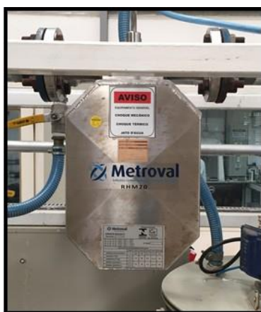
Figura 3.9: Transmissor indicador de densidade (DIT-05) e Vazão (FIT-08). Fonte: FER-RAZ(2019).
