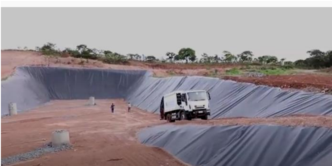
Figura 1: Exemplo de aterro por trincheira. Fonte: Aterro Sanitário Municipal Hidrolândia – GO. Youtube https://www.youtube.com/prefeituradehidrolandiago .
