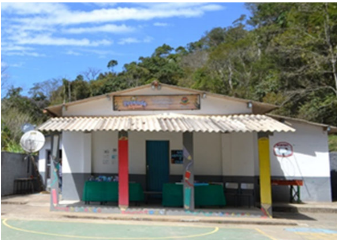
Figura 11 - Escola Municipal Fazenda Alpina em 2018, após diversas obras realizadas no prédio escolar.
