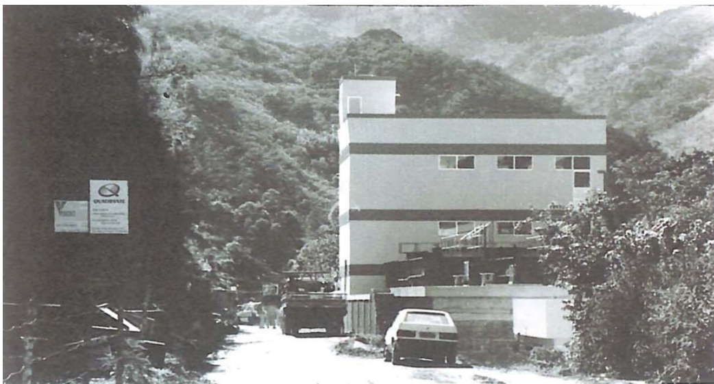
Quadro 23 – Instalação da CEDAE – Francisco Fragoso (Miguel Pereira)
