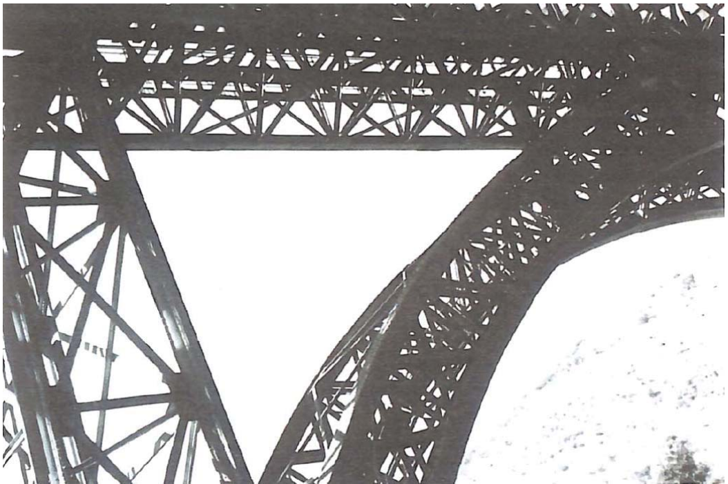
Quadro 21 – Viaduto Paulo de Frontin – Vera Cruz (Miguel Pereira)
