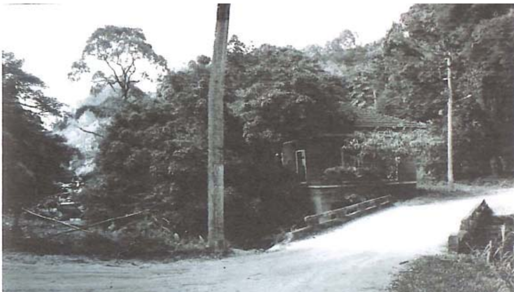
Quadro 25 – Ruínas das instalações da Usina Hidrelétrica de Vera Cruz (Miguel Pereira) – da LIGHT
