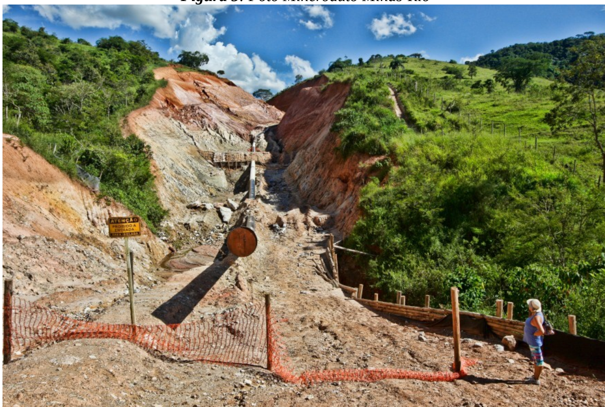
Figura 5: Foto Mineroduto Minas-Rio
