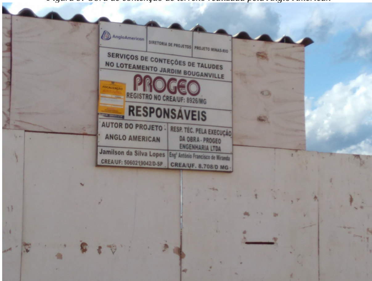
Figura 9: Obra de contenção de terreno realizada pela Anglo American
