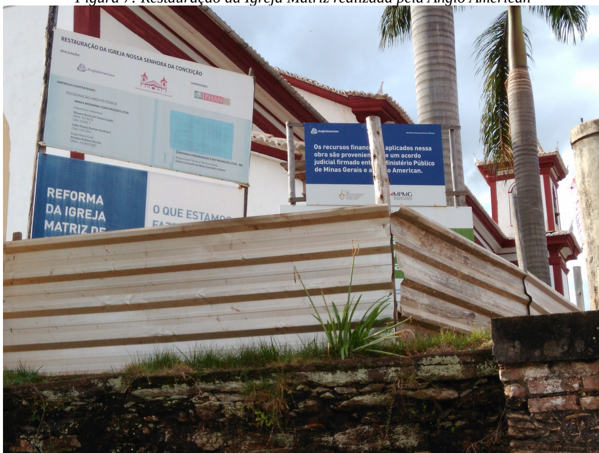
Figura 7: Restauração da Igreja Matriz realizada pela Anglo American
