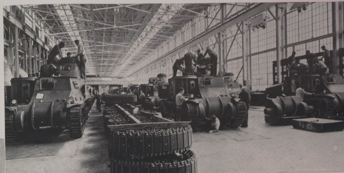
Por ser a fabricação de tanques essencialmente um problema de montagem—que a indústria de automóveis conhece tão bem, as fábricas de Detroit têm tido parte proeminente na produção dessas máquinas de guerra. Em cima: O possante M-3 de 28
