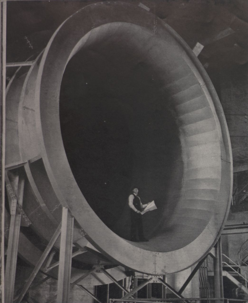
Na boca deste gigantesco tunel de vento, de aço inoxidável, os aeroplanos são postos à prova em condições similares às de verdadeiro voo. Dois potentes ventiladores dotados de dezesseis pás, fazem a sucção do ar através da câmara de prova, a uma velocidade de 400 milhas por hora. Em baixo: No terraço de uma fábrica de automóveis, centenas de carros "jeeps" estão alinhados aguardando transporte para as várias frentes de batalha
