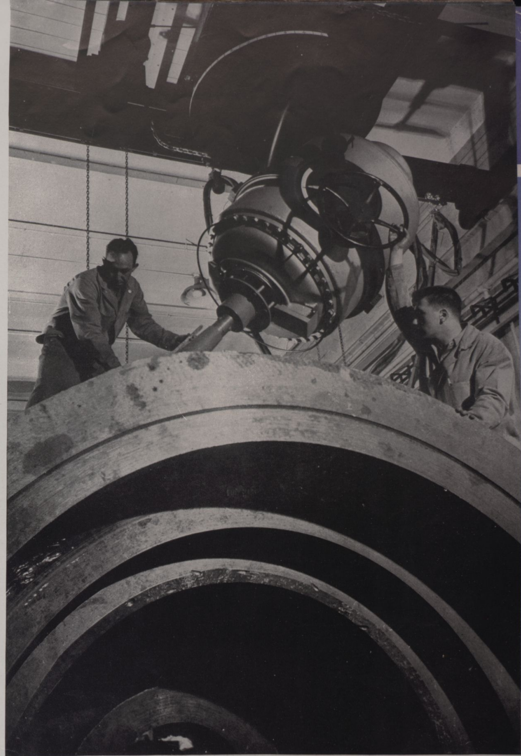
Com instrumentos científicos como este aparelho de raios X, a indústria examina os seus produtos. A radiografia de um milhão de volts da turbina deste navio revelará qualquer defeito na fundição da mesma. Os detalhes mais insignificantes são submetidos a rigoroso exame
