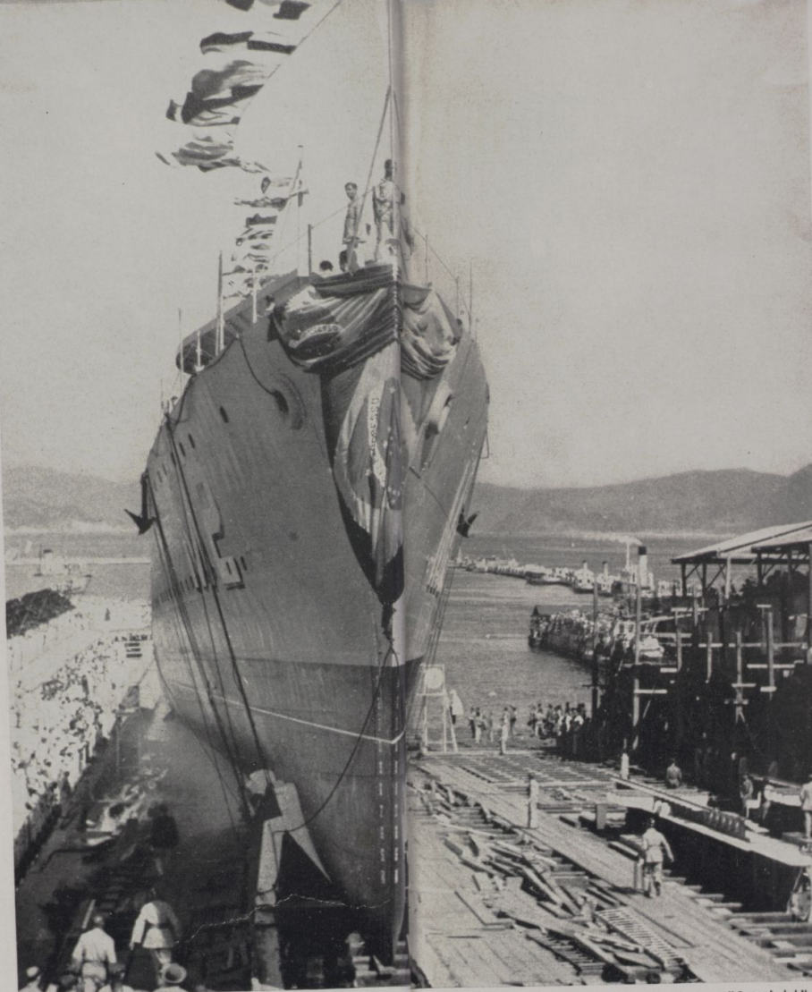
O destroyer "Mariz e Barros", ao ser lançado ao mar dos estaleiros do Arsenal de Marinha do Rio de Janeiro. Desloca 1.500 toneladas, como dois outros do mesmo tipo, o "Greenhalgh" e "Marçílio Dias". Seis mais estão em construção nesse arsenal
