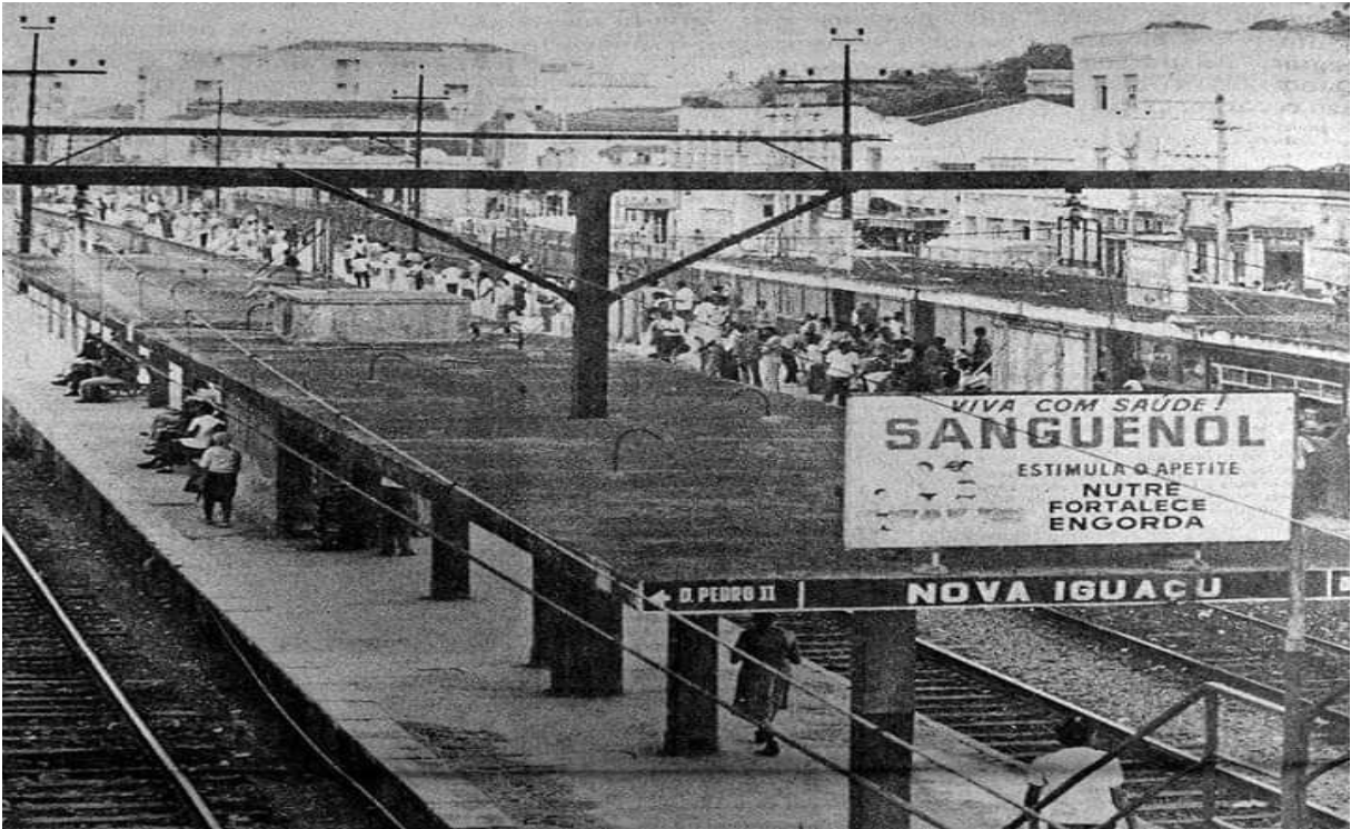
Figura 16 - Estação Ferroviária de Nova Iguaçu, 1972
