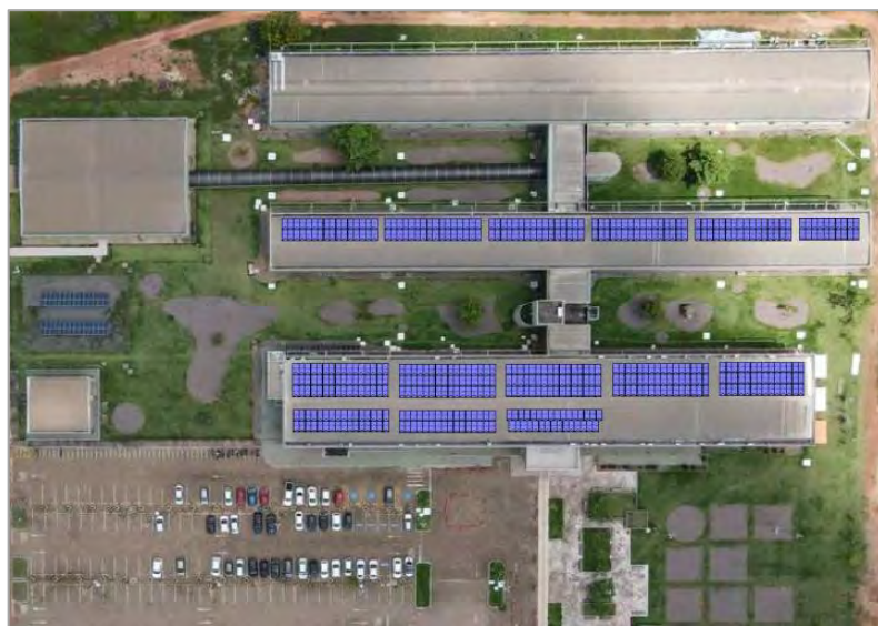
Figura 17 - Vista aérea do Layout de instalação das placas solares
