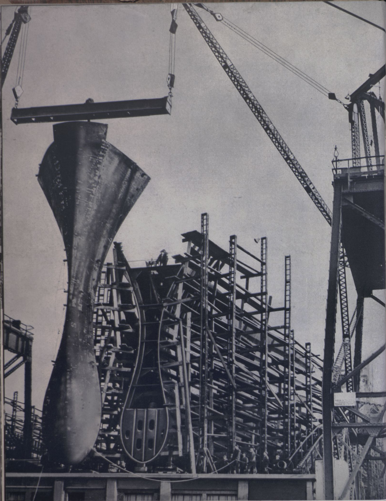
A prôa de um navio petroleiro reúne-se ao resto do casco. A fabricação prévia de várias partes do navio reduz extraordinariamente o tempo de construção
