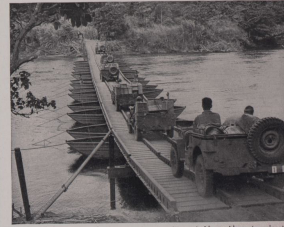
Os prodigiosos "jeeps" passam por uma ponte construída rapidamente pelas tropas de engenharia, que se servem dos pontões para abreviar as vias de comunicações
