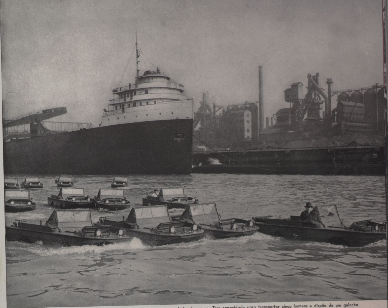
Tanto em terra como na água, o "Jeep" anfíbio funciona perfeitamente como um veículo de guerra. Tem capacidade para transportar cinco homens e dispõe de um guincho para facilitar a sua subida em barrancos, por meio de um cabo de aço que pode passar-se em qualquer tronco de árvore, à margem de um rio. Seu potente motor é estanque
