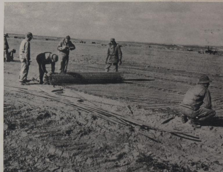
A guarnição de terra desenrola uma das seções da rede de aço sobre a lama, num dos aeródromos na Tunísia. O entrelaçado da rede permite o crescimento do capim através dos orifícios, servindo de camuflagem
