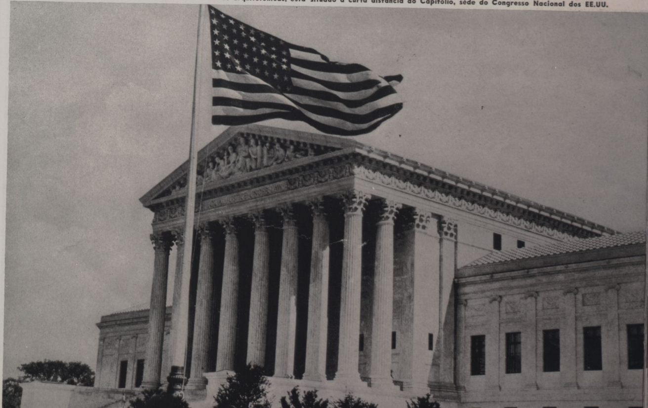
O novo edifício da Corte Suprema, modelar em suas linhas arquitetônicas, está situado a curta distância do Capitólio, sede do Congresso Nacional dos EE.UU.
