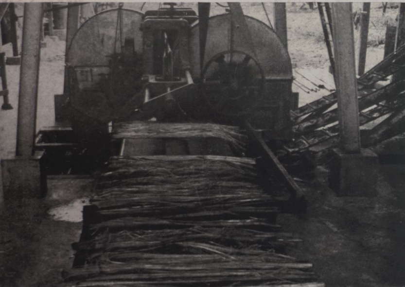
A fibra abacá sendo preparada para o mercado. Faz-se o corte de várias camadas da fibra, que é passada na máquina, para remover a matéria celular de pouca consistência. A fibra é depois secada (em baixo) em canos de ferro, ao ar livre. Depois de seca, é classificada e embalada, pronta para ser embarcada. A sua aplicação na fabricação de cordoalha vem substituir agora o produto que era cultivado antes nas ilhas Filipinas
