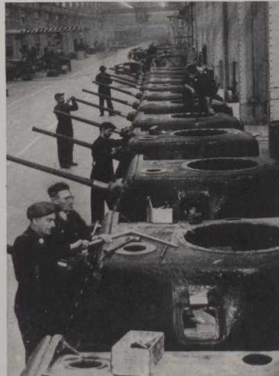
Vista do intenso trabalho de montagem de tanques na fábrica de Ram, que pelas suas dimensões e pela quantidade de sua produção, é a segunda fábrica no gênero, no mundo
