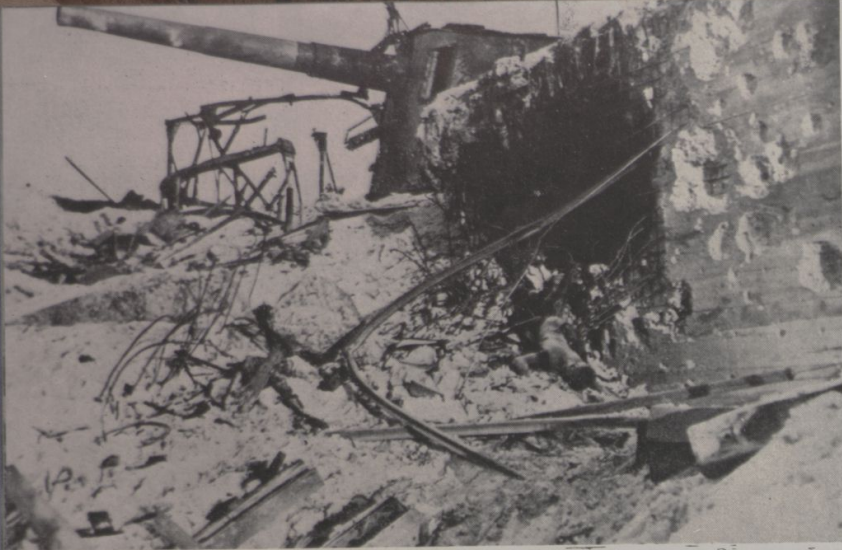
A tremenda explosão causada por uma granada de grosso calibre foi o único meio de destruir esta fortificação. Os lança-chamas também surtiram efeito para reduzir ao silêncio as fortificações japonesas em Tarawa
