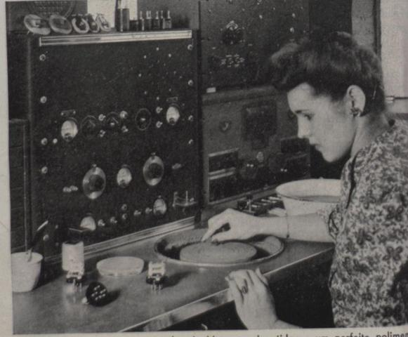
Pequenas placas são cortadas do bloco e submetidas a um perfeito polimento. Determina-se a exata espessura da placa por meio de repetidas provas num circuito elétrico, antes de utilizá-la em vários e importantíssimos aparelhos de precisão
