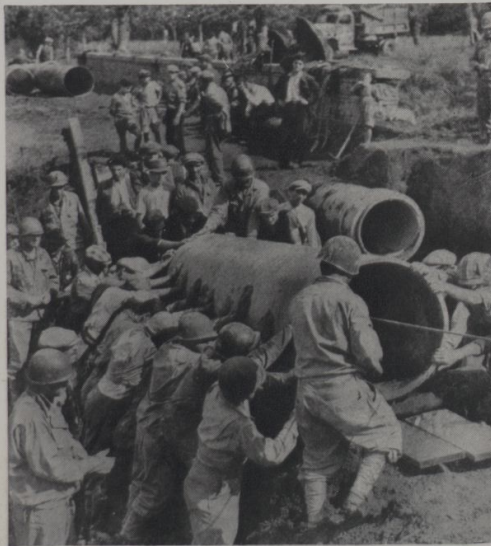
Trabalhadores italianos ajudam os soldados aliados na reconstrução do grande aqueduto de Nápoles, destruído em sete lugares, pelos alemães
