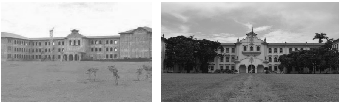
Figura 16: Imagem da fachada em construção e concluída do prédio P1 da UFRRJ
