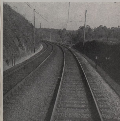
A eletrificação ferroviária é parte importante no programa das Américas. Aqui vemos um trecho eletrificado da Estrada de Ferro Paulista
