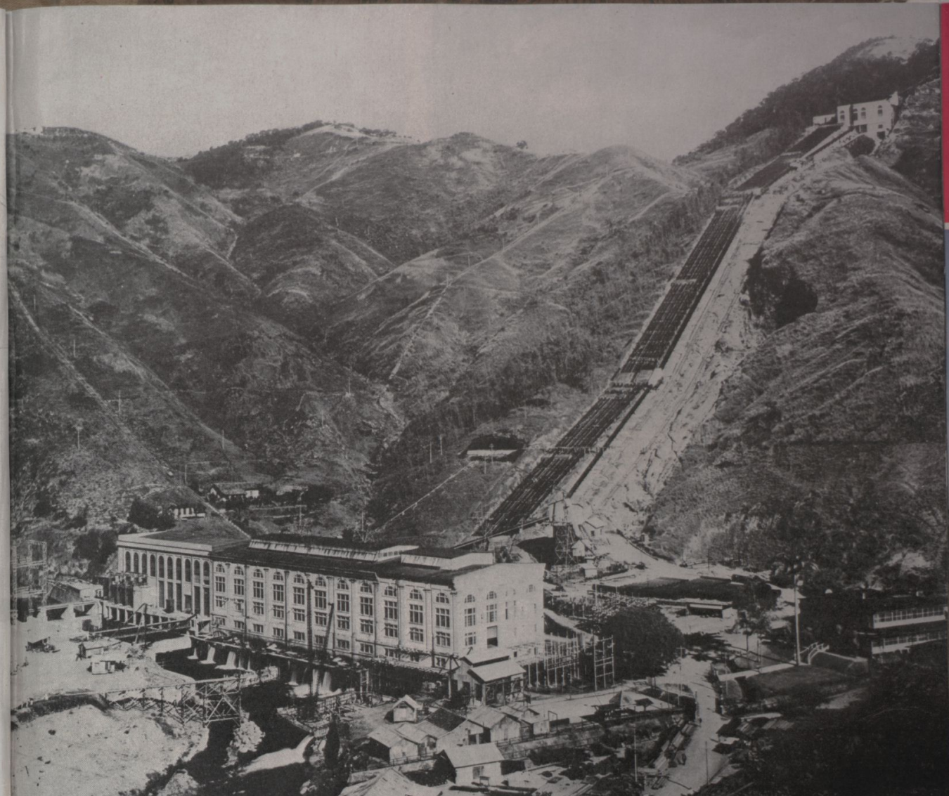
A grande usina de Ribeirão das Lages, uma das maiores do Brasil, cujos vastos recursos hidro-elétricos são calculados em dezenove milhões de quilowatts
