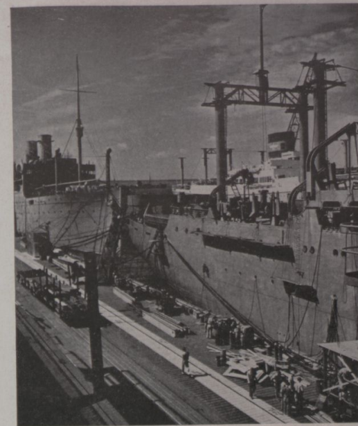
Navios cargueiros em vias de conclusão em Newport News, no Estado de Virgínia. Outros grandes estaleiros são os de Mobile e o de Nova Orleans
