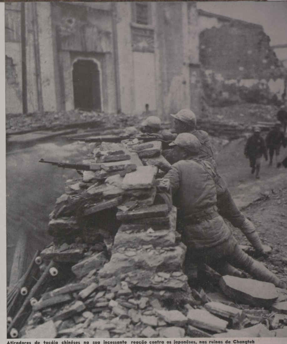
Atiradores de tocaia chineses na sua incessante reação contra os japoneses, nas ruínas de Changteh
