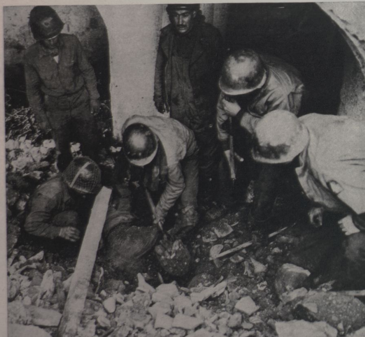
Em Cerasuolo, na Itália: soldados americanos, de infantaria, salvam um companheiro, dos escombros de um edifício atingido por uma bomba. São riscos a que se expõem constantemente as tropas da velha arma
