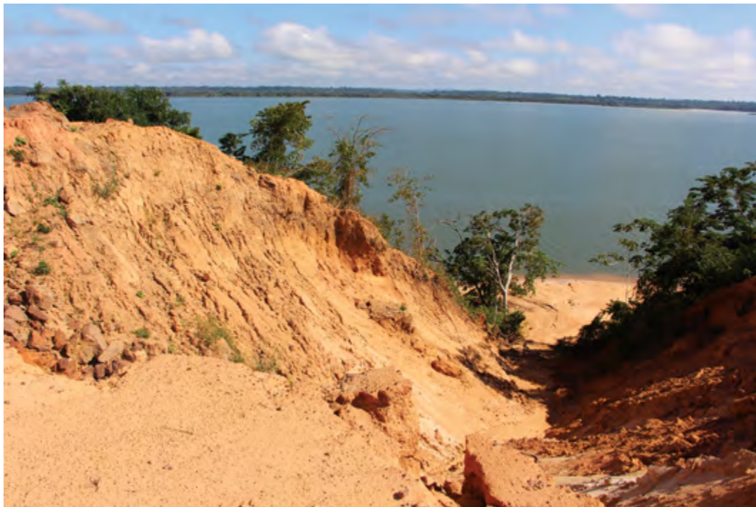
Terreno sendo terraplanado para futura instalação portuária em Santarenzinho
