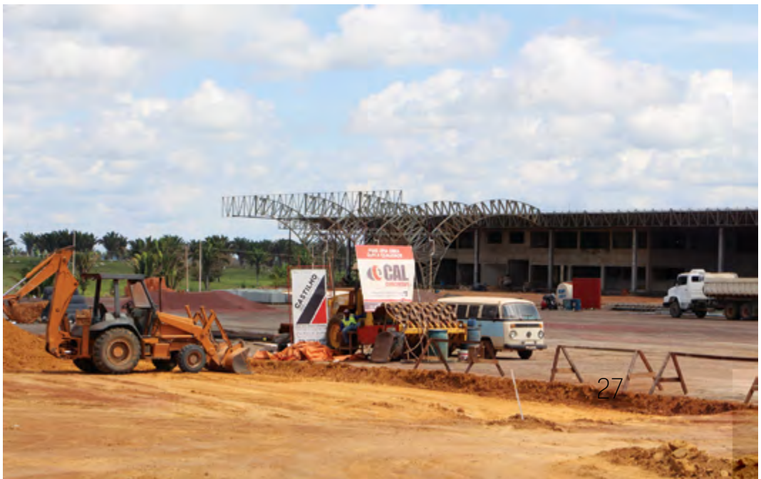
Posto em construção na BR-163
