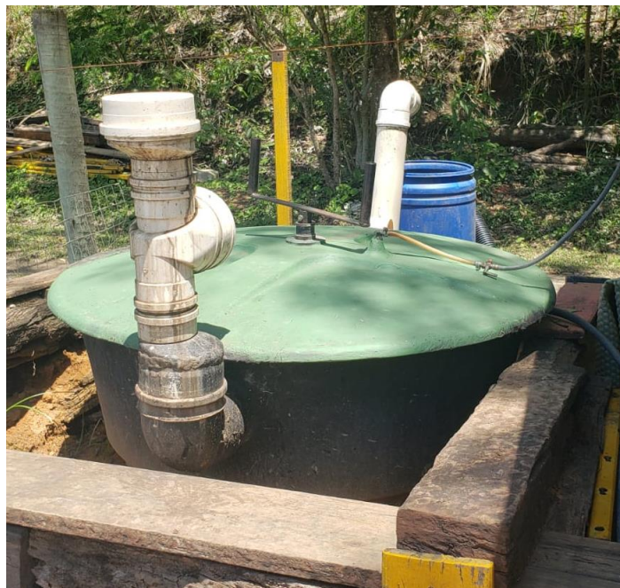
Figura 42: Biodigestor do CEA feito com uma caixa d'água. (Fonte: A autora).
