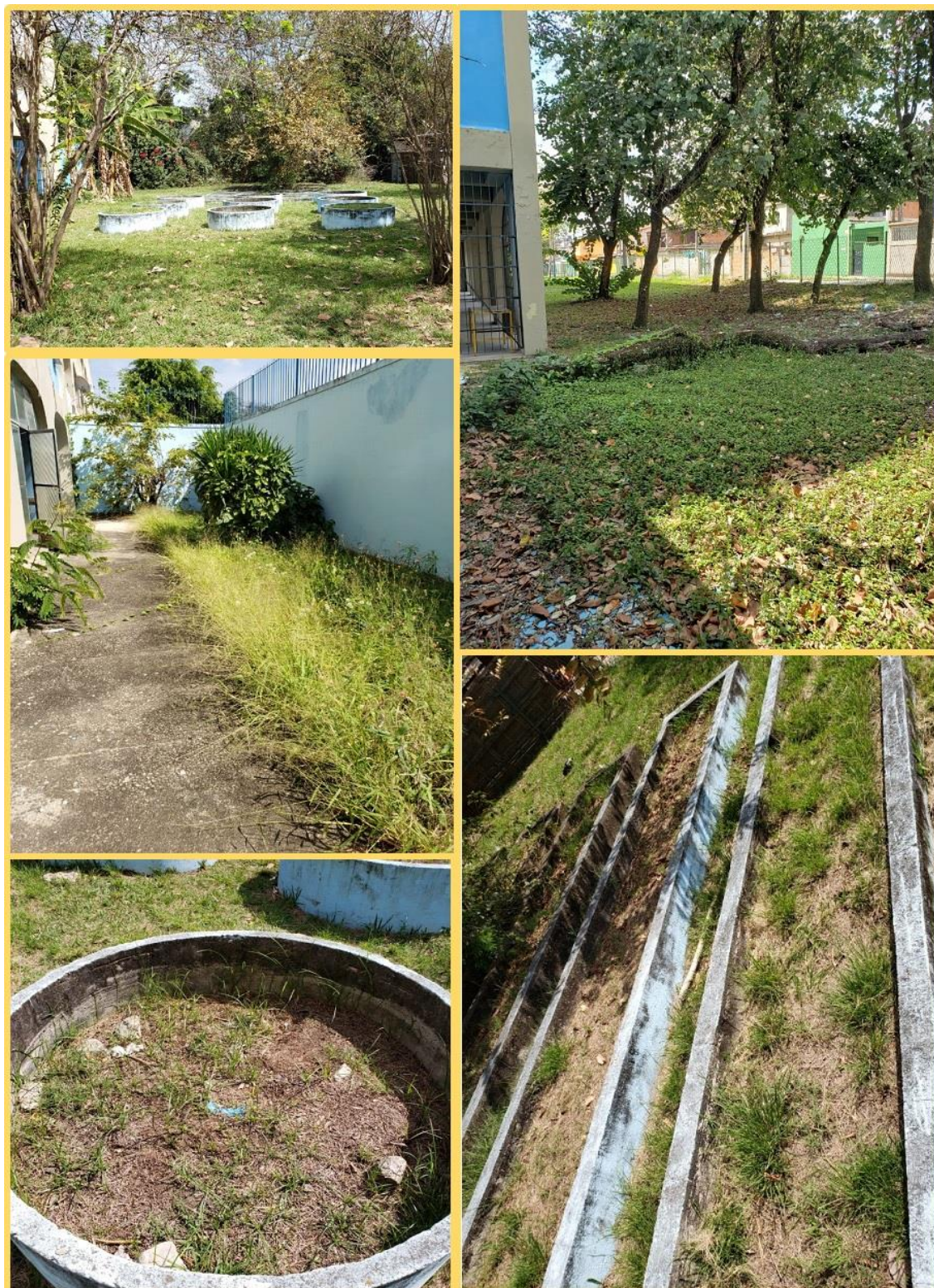
Figura 14: Espaços do Ciep 224 – Tarso de Castro que poderiam ser usados para compostagem que esporadicamente são usados para alocação de entulho e material de obra. Há também espaços disponíveis para possíveis hortas na parte da frente como no externo do refeitório onde seria possível o plantio de hortaliças para a feitura das merendas ou distribuição na comunidade escolar. (Fonte: A autora).
