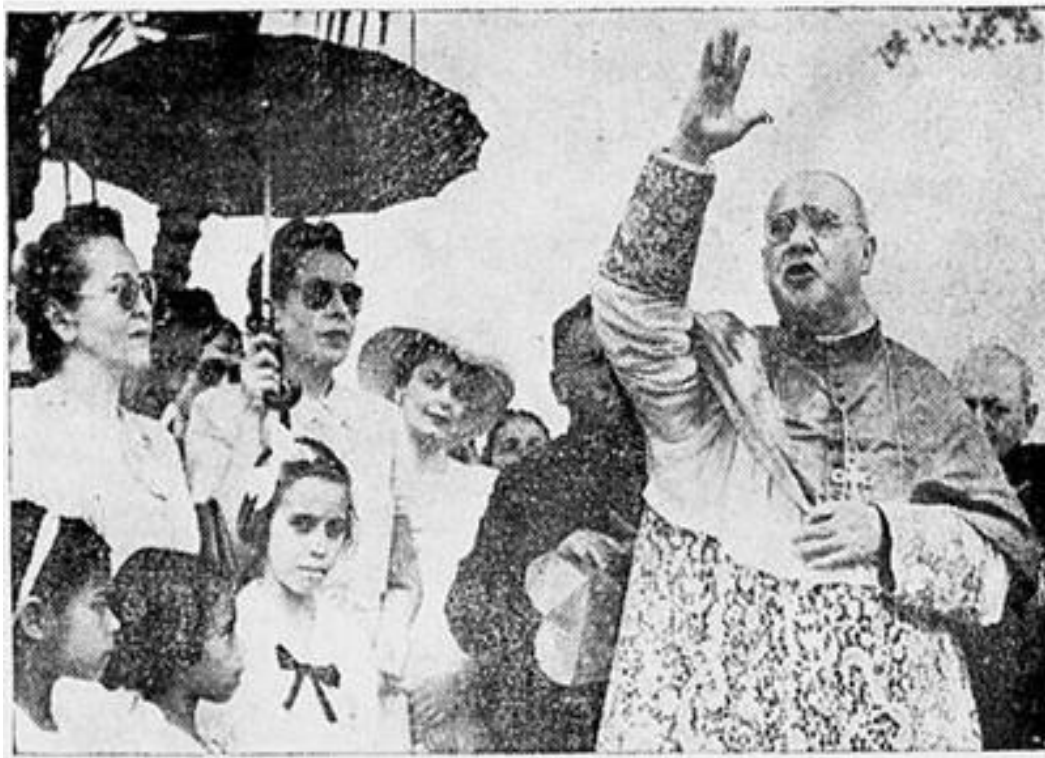
Figura 19 O Lançamento da Pedra Fundamental na Cidade das Meninas.
