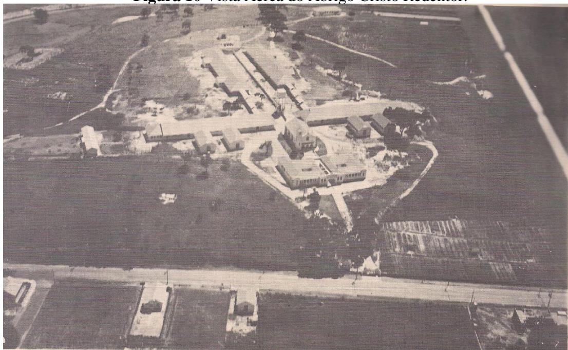
Figura 10 Vista Aérea do Abrigo Cristo Redentor.
