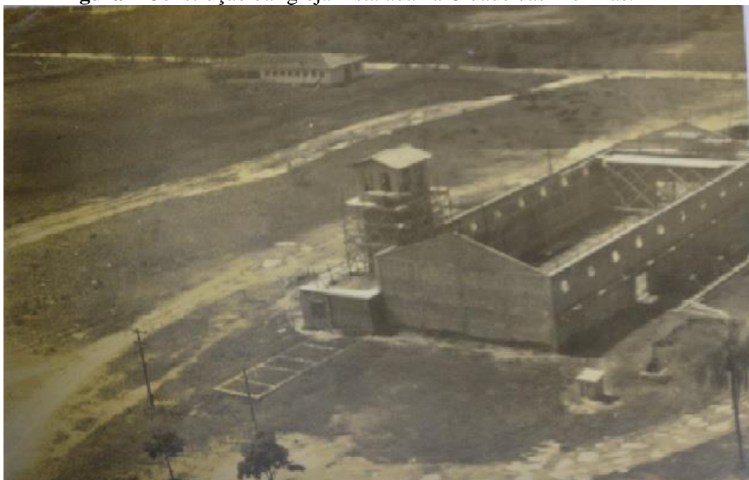
Figura 4 Construção da Igreja instalada na Cidade das Meninas.
