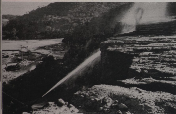
Engenheiros brasileiros e norte-americanos examinando um motor Wright-Whirlwind, enviado pela Wright Aeronautical Corporation para ajudar o treinamento de mecânicos. Em baixo: Arrazando a jato d'água as colinas no local onde está agora a Fábrica Nacional de Motores, cujo pavilhão principal mede mais de 200 metros de comprimento
