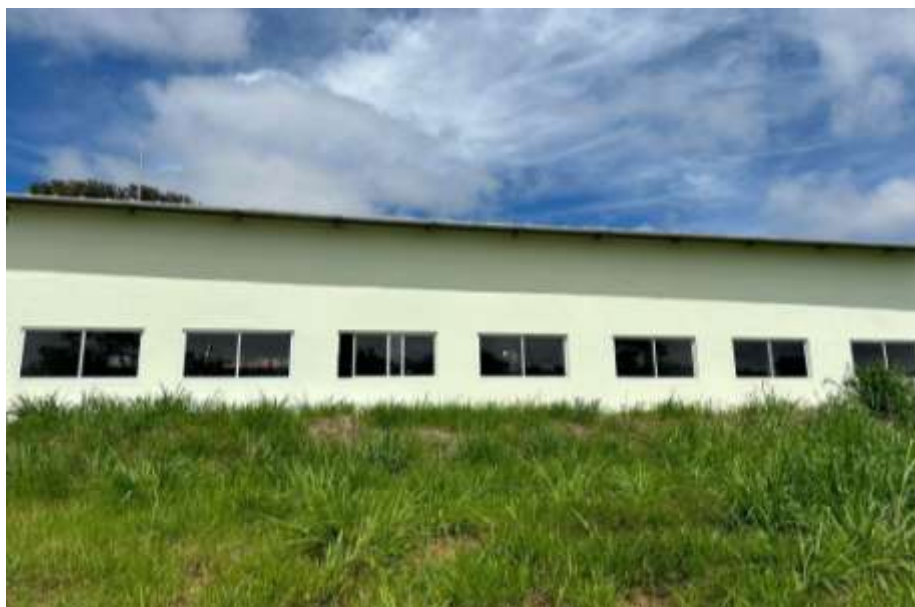
Figura 17. Fachada nordeste da edificação - salas de aula.
