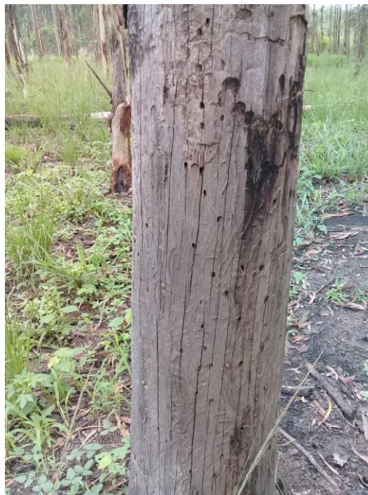
Figura 10. Árvore apresentando rachaduras longitudinais e orifícios em plantio de eucalipto na Floresta Nacional Mário Xavier, Município de Seropédica, Estado do Rio de Janeiro.
