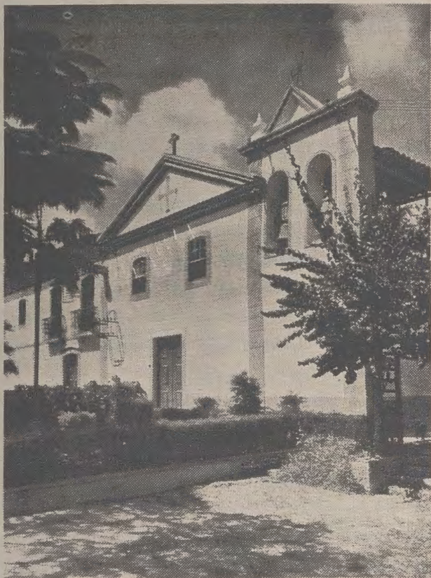
Fachada principal da igreja e casa da fazenda de São Bento
