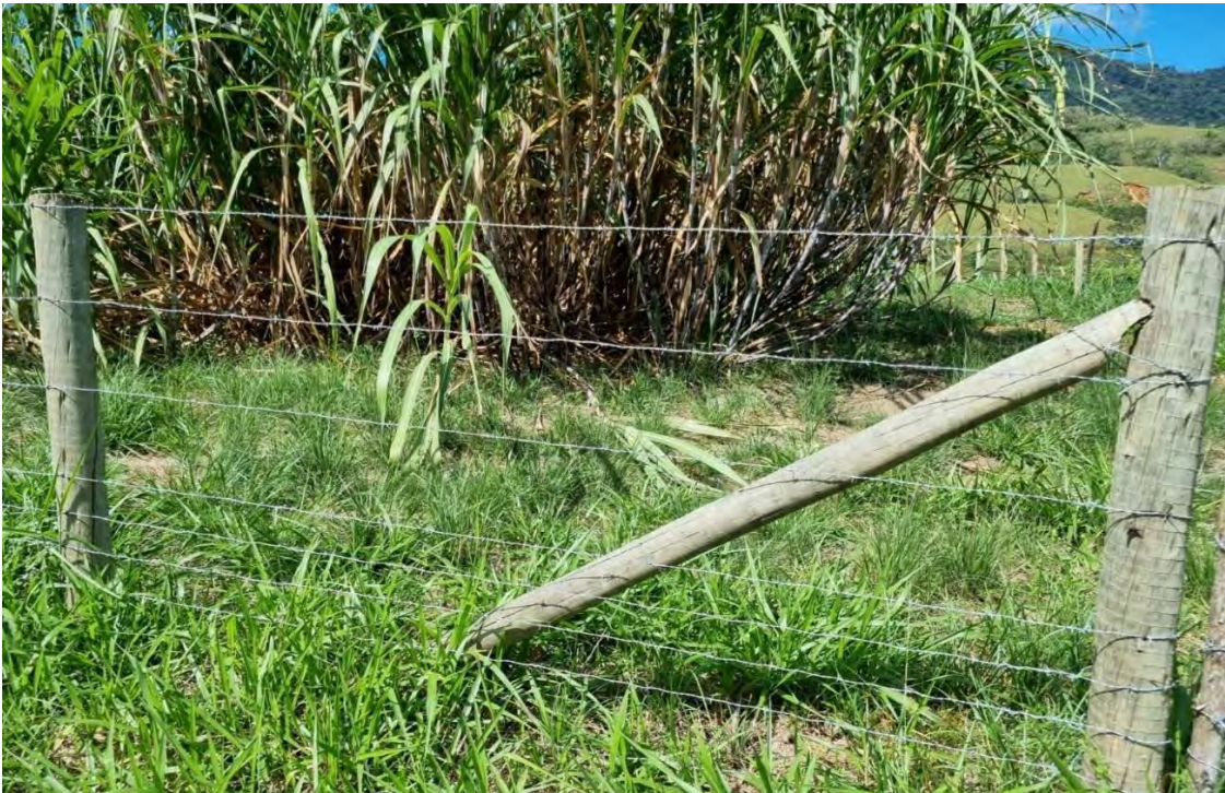
Figura 26. Cerca confeccionada com 7 fios em área experimental de canavial orgânico, no qual os quatro fios inferiores são espaçados em 30 cm, Gleba G27.
