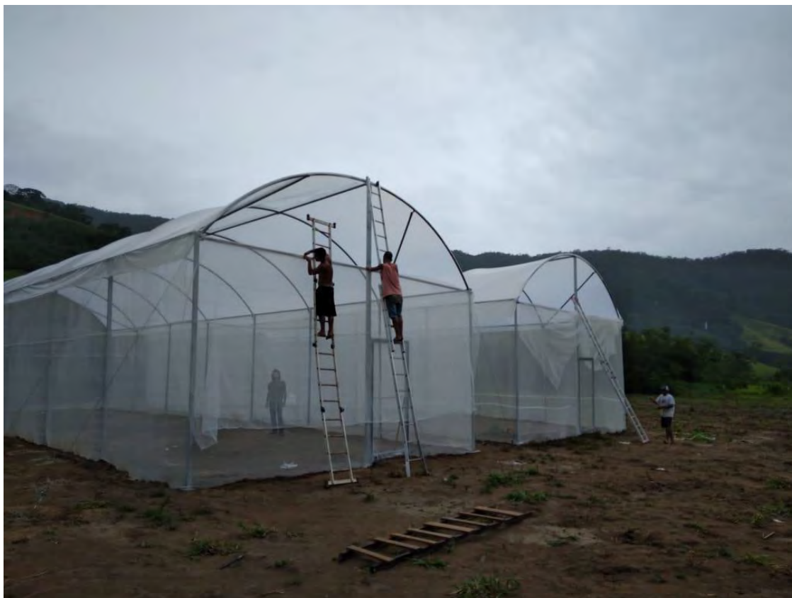
Figura 27. Finalização da montagem das duas (01) estufa de área útil protegida de 504m 2 .
