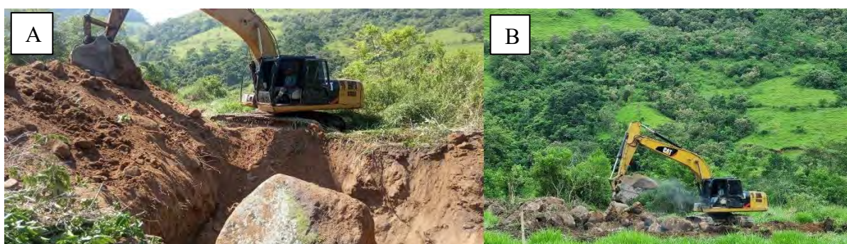
Figura 21. Composição de Imagens. A. Retirada de Fragmentos Rochosos sob as áreas de cultivo do Horto da Biodiversidade, com retroescavadeira hidráulica operada pelo Sr. Peixoto da empresa A4. B. Deposição das pedras de forma estratégica.
