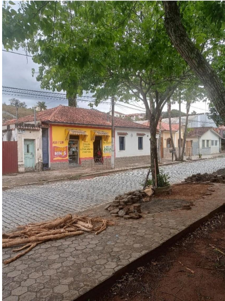
Figura 15 Poda de raízes realizada pela Secretaria Municipal de Obras
