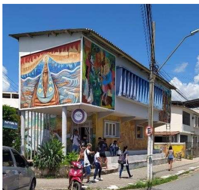
Figura 14 Vista da fachada frontal do PAC após pintura mural, 2022.
