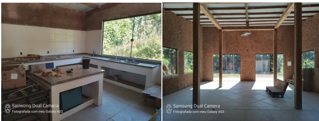
Foto 13 - Novo restaurante de Tapera ainda em construção
