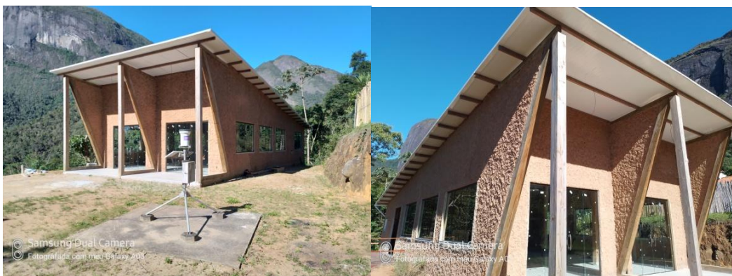
Foto 12 - Novo restaurante de Tapera ainda em construção
