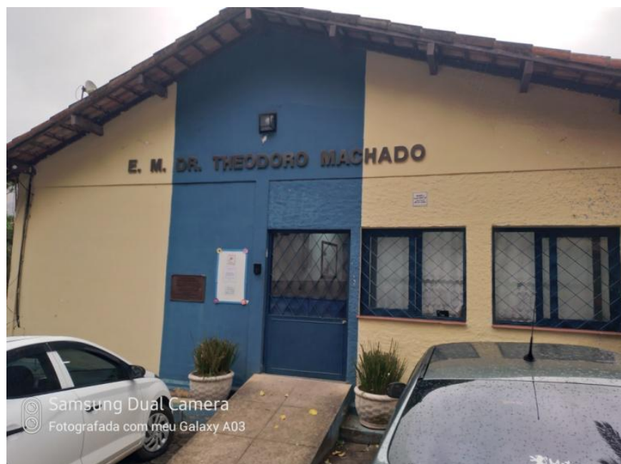
Foto 15 - Fachada da E. M. Dr. Theodoro Machado
