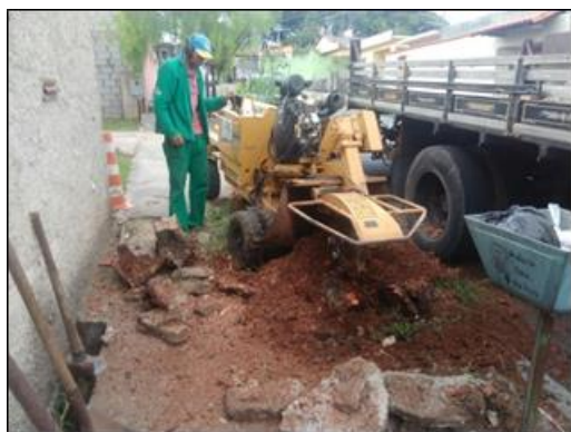
Figura 49: Destoca executada pelo contrato emergencial. (Foto do autor).
