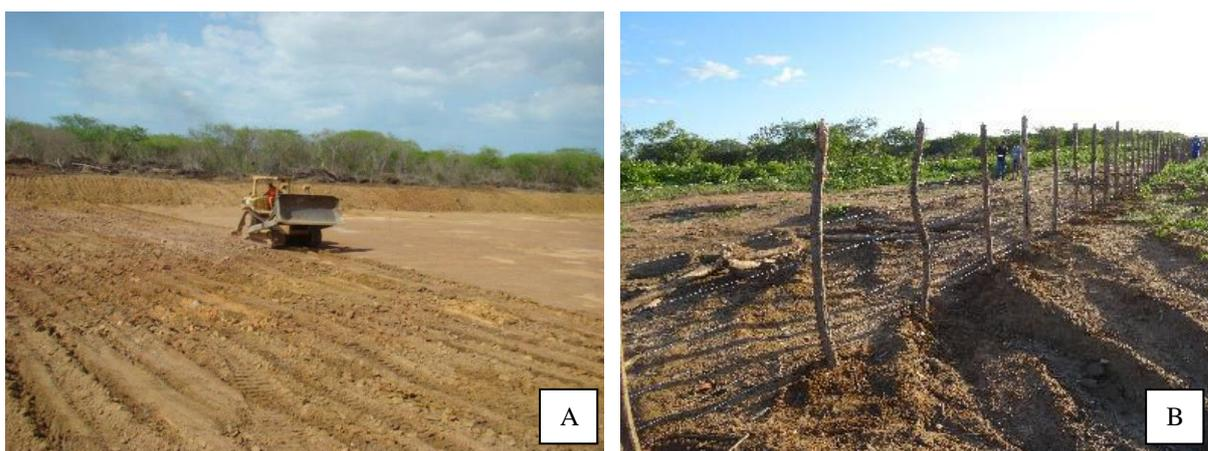
**Figura 11.** Escarificação da área J-111 com auxílio de trator de esteira acoplado a um escarificador antes da instalação do experimento (A) e cerca construída no perímetro da área (B) (Assú-RN).
