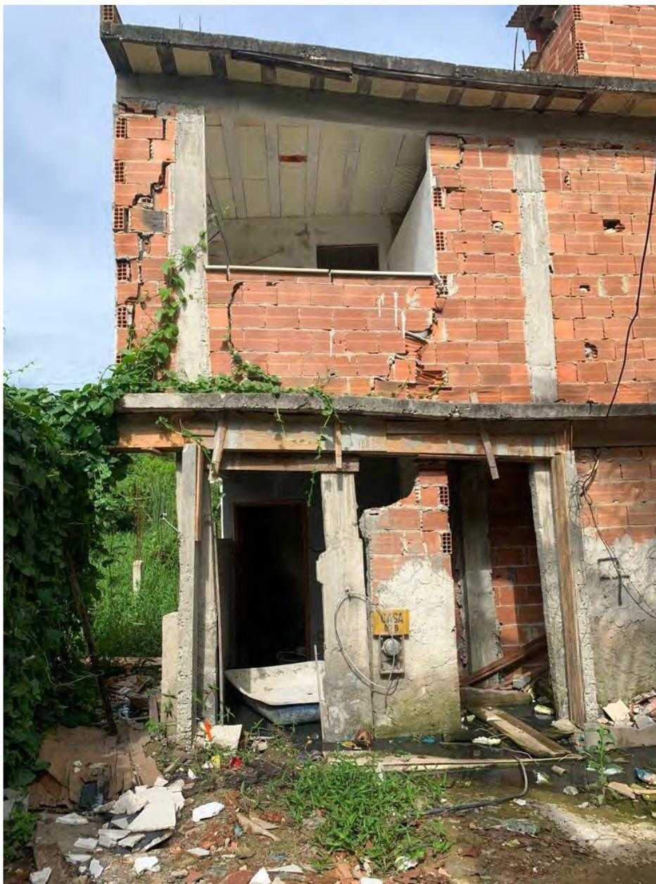
**Figura 19:** Casa foi abandonada após o rápido alagamento e colapso da estrutura. Fonte: Próprio autor.
