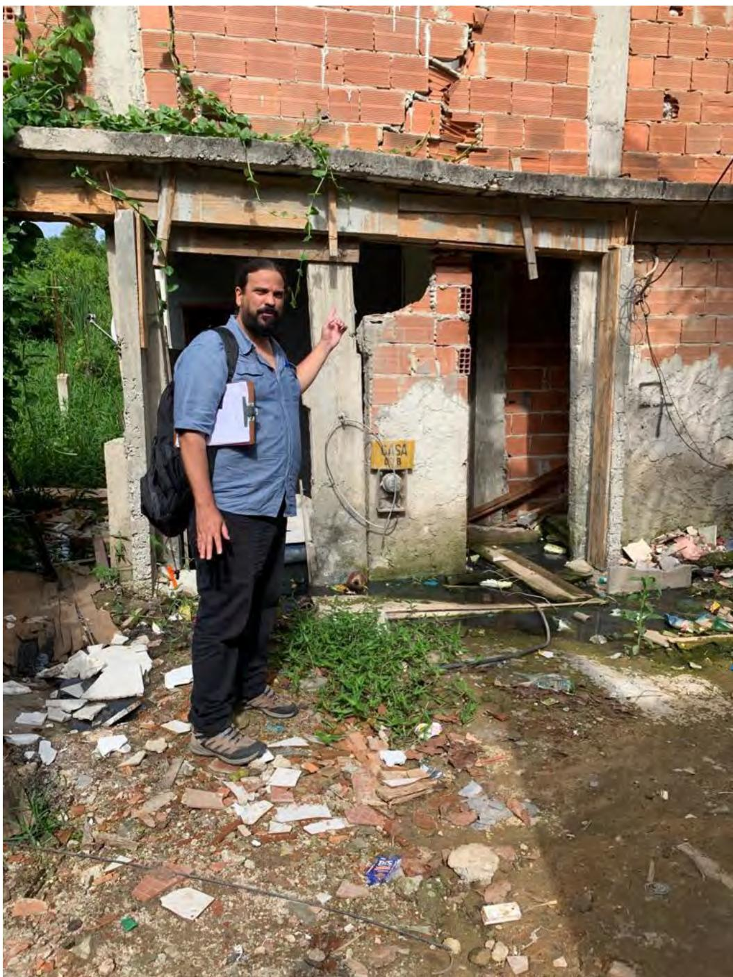
**Figura D1** - Edificação condenada em terreno cedendo.
