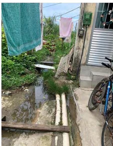
**Figura 14:** Foto de saídas de esgoto lançado diretamente no terreno alagado. Fonte: Próprio autor.
