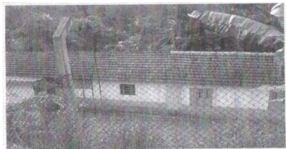
Figura 14 - Antigo prédio da Escola Fazenda da Lapa (1965)
