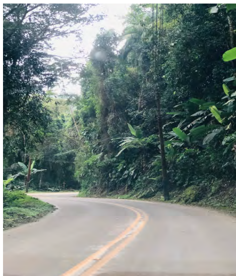
Figura 9 - Trecho asfaltado da Estrada RJ-14 Fonte: arquivo da autora, 2022.
