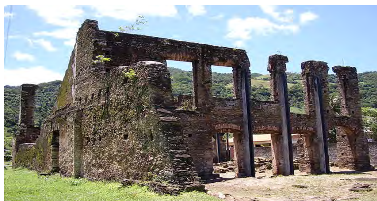
Figura 10 - Ruínas na Estrada São João Marcos
