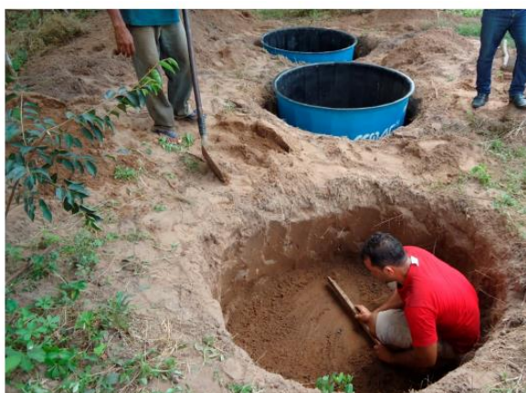
Figura 15 – Escavação e Montagem do sistema FSB Fonte: EMBRAPA, 2017
