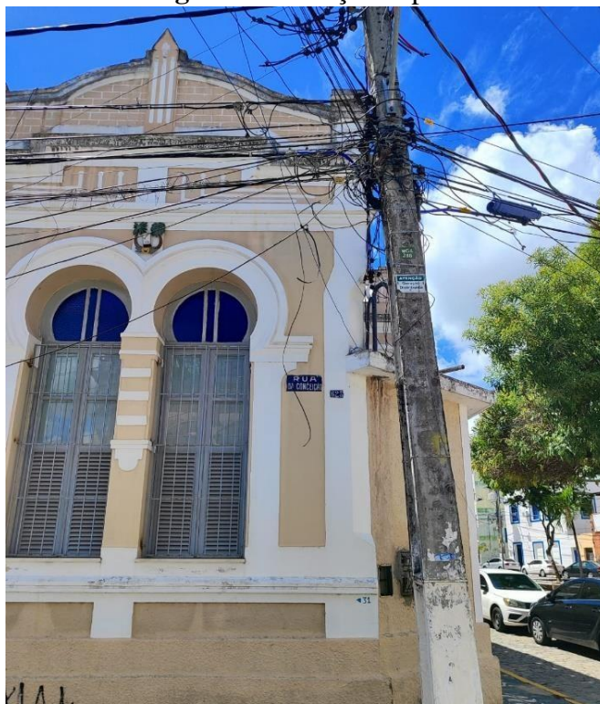
Figura 22 – Fiação exposta
