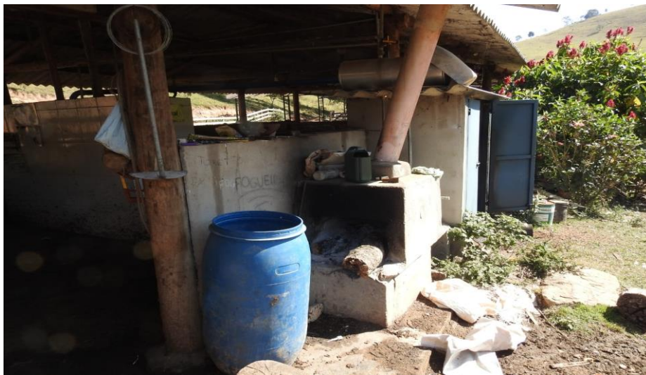
Figura 20. Fogão de lenha na lateral do curral com serpentina para aquecimento da água usada na lavagem do sistema de ordenha. Fonte J. Felipe
