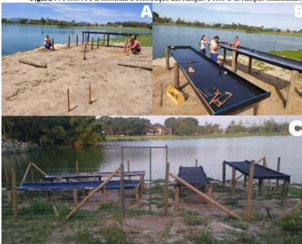
Figura 9: Fotos A e B mostram a construção das rampas e foto C as rampas finalizadas.
