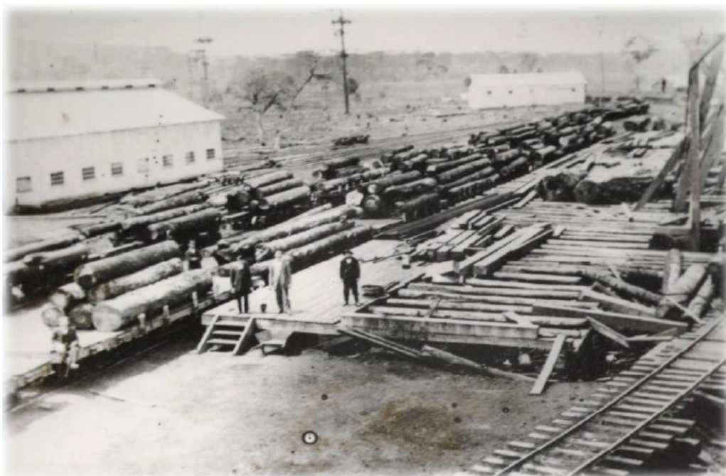
Figura 2. Embarque de vagões com toras na mata. O trabalho era efetuado com a ajuda de guinchos movidos a vapor comprimido, s/d. Imagem digitalizada. MTB (Museu de Três Barras)
