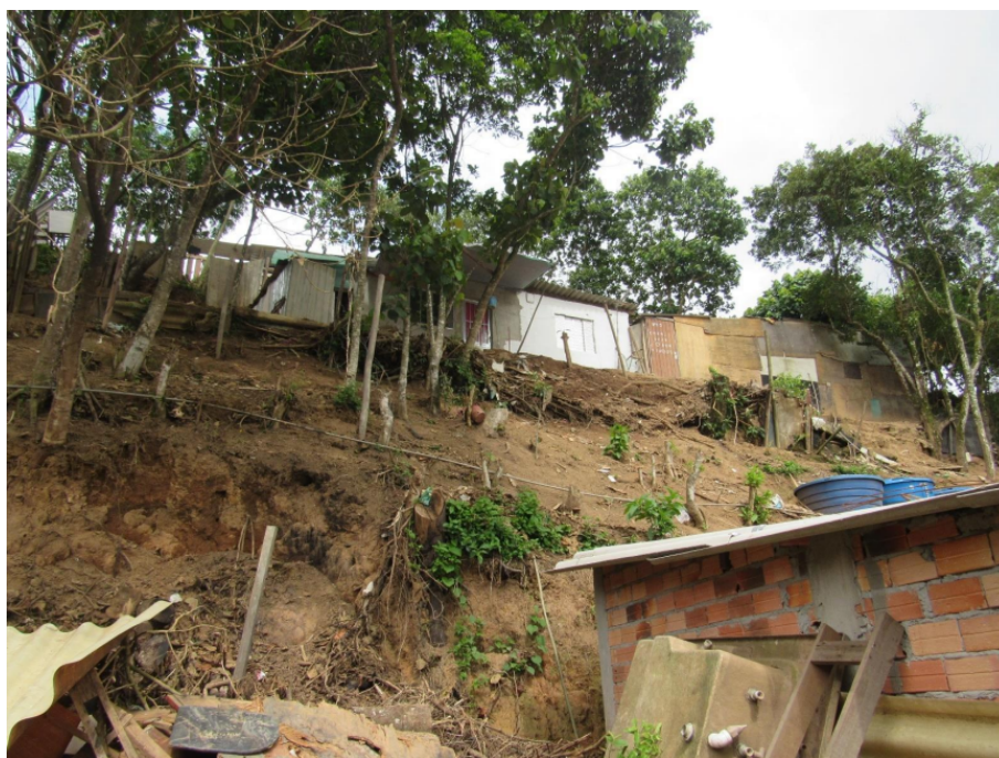
Figura 3.2: Destaque para situação da encosta com solo exposto, cicatriz de deslizamento, árvores inclinadas.
