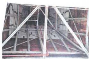
Estrutura metálica específica da cobertura do torreão existente
