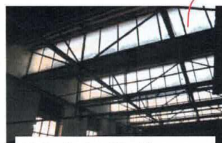
Telhado tipo “Shed” existente em um dos galpões
