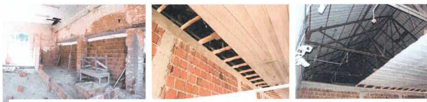
Obras irregulares em andamento com o emparedamento de vãos, colocação de forros impedindo a visibilidade das estruturas originais de telhados e outras que deverão ser apontadas e consideradas como dano
