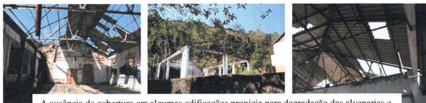
A ausência de cobertura em algumas edificações propicia para degradação das alvenarias e das estruturas de telhados expostas.
