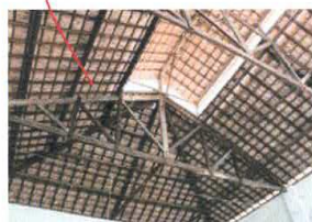
Estrutura do telhado existente em um dos galpões, executada em madeira e recobrimento com “telhas cerâmicas tipo francesa”
