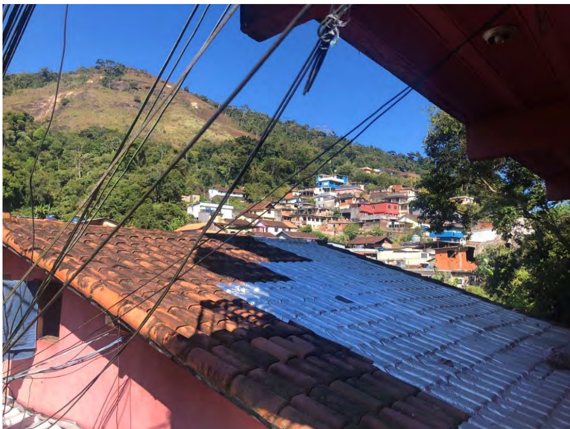
Figura 62: Casa com manta aplicada sobre o telhado Fonte: Autoria própria
