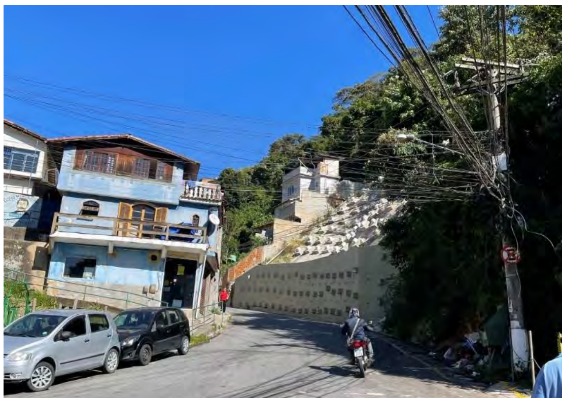
Figura 40: Depois: muro de contenção na Rua 24 de Maio. Junho/23. Fonte: autoria própria
