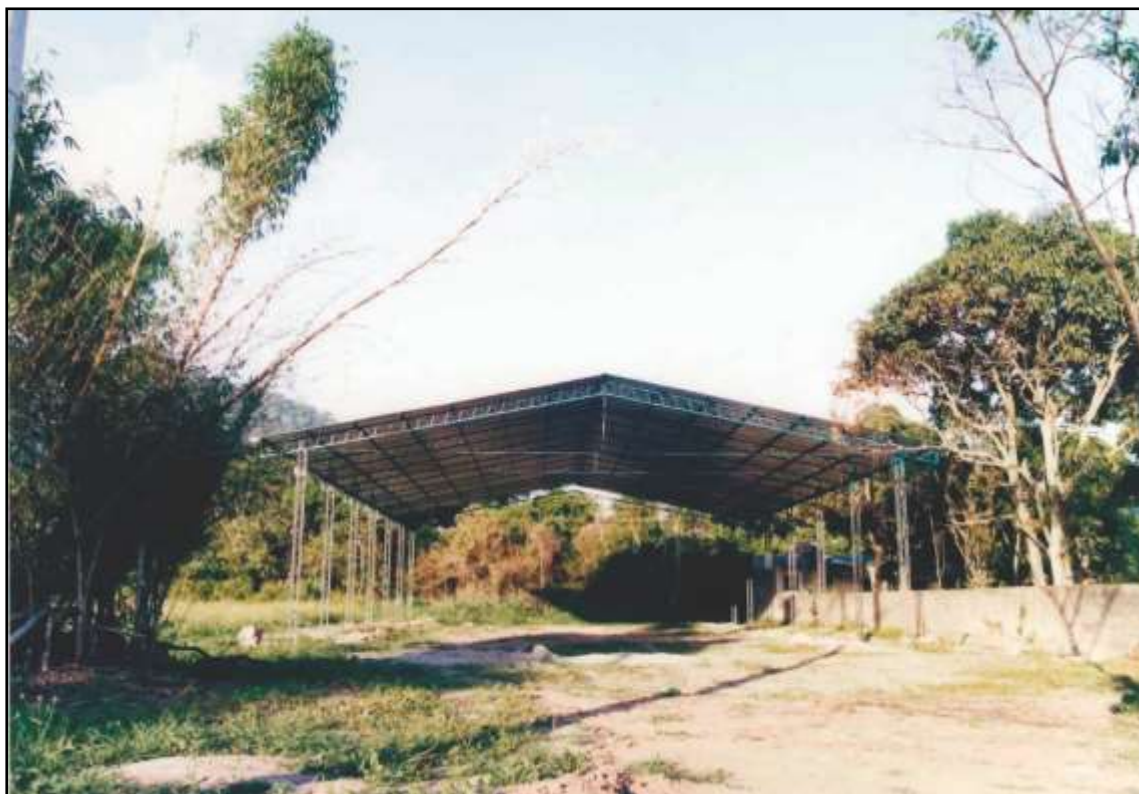
Figura 9: Cobertura já montada
