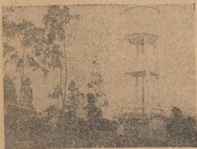
No flagrante um aspecto da caixa d'água com capacidade para 20 mil litros, vendo-se abaixo a casa onde estão localizadas as bombas que levam o precioso líquido ao depósito.
