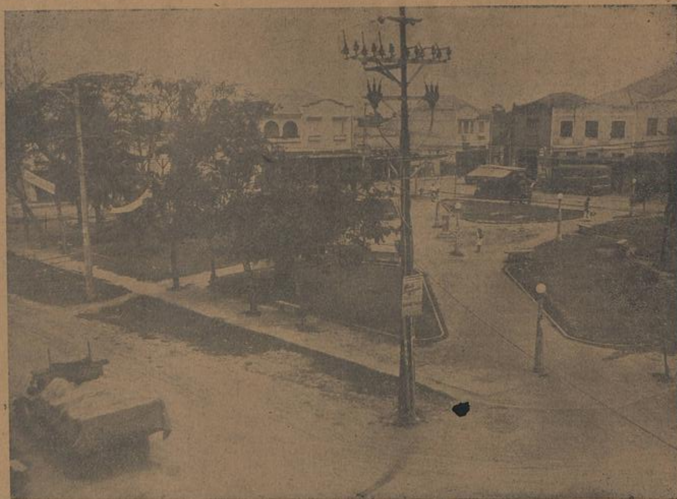
Praça Manoel Duarte, em Mesquita — Ajaruinamento e iluminação, obra da administração Paulino Barbosa
