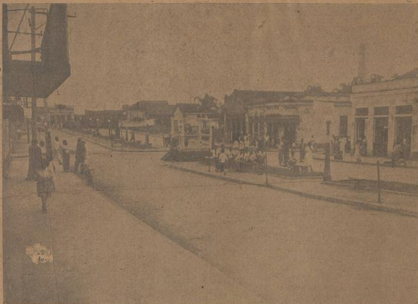
Praça Getúlio Vargas, em Belfort Rôzo, com calçamento, iluminação, ajardinamento e rede de esgotos. Obra das administrações Getúlio Moura e Paulino Barbosa
