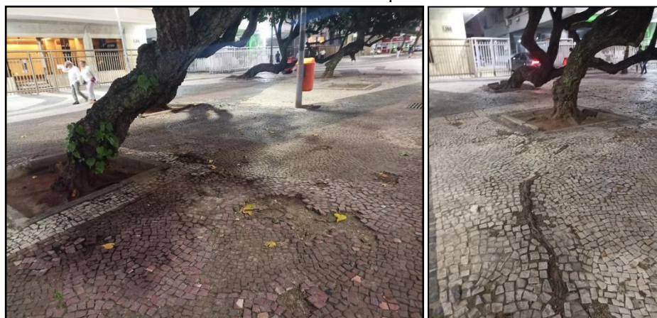
Figura 77 – Raízes causando rachaduras e desníveis na pavimentação. Avenida Atlântica – Copacabana.
