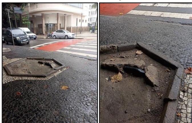
Figura 95 – Problemas estruturais: gola de árvore obstruindo a rampa acesso. Avenida Atlântica – Copacabana.
