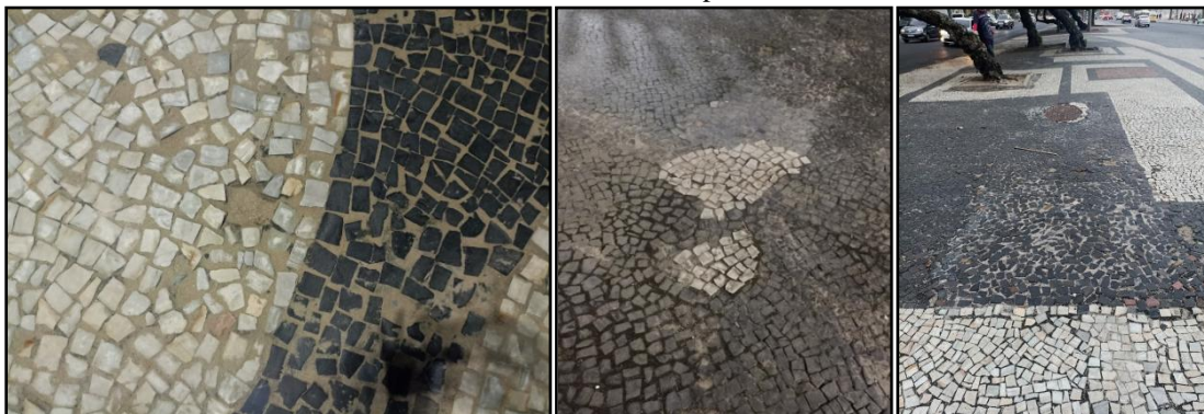
Figura 79 – Manutenção irregular – juntas largas, remendos e pedras fixadas com cimento. Avenida Atlântica – Copacabana.
