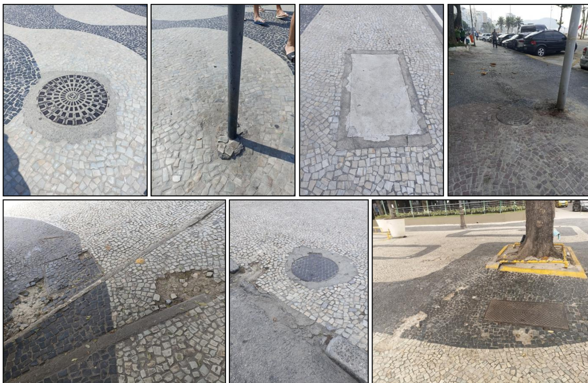
Figura 97 – Problemas estruturais: manutenção irregular, buracos e raízes causando desníveis no pavimento. Avenida Atlântica – Copacabana.
