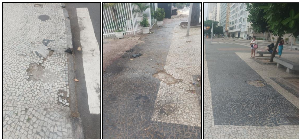
Figura 60 – Buracos e pedras soltas na frente da rampa de acesso e próximo aos bancos. Avenida Atlântica – Leme.
