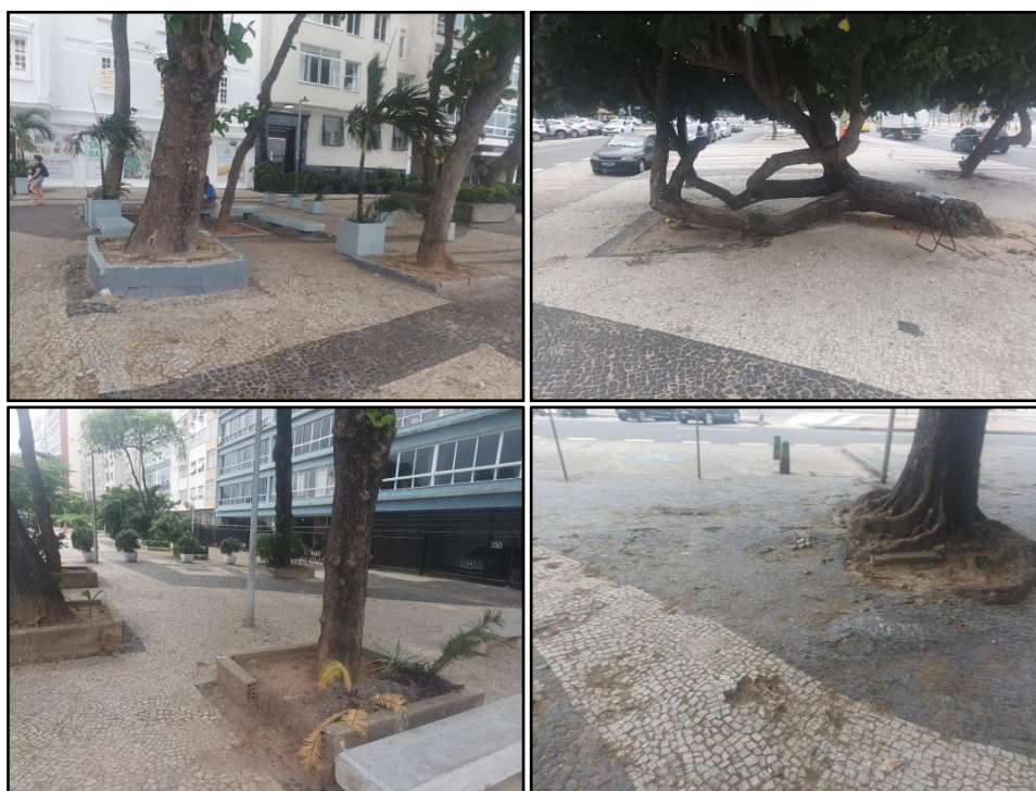
Figura 61 – Raízes causando rachaduras e desníveis na pavimentação. Avenida Atlântica – Leme.
