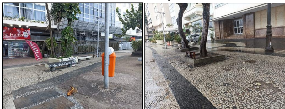
Figura 94 – Problemas estruturais: buracos e manutenção irregular. Avenida Atlântica – Copacabana.
