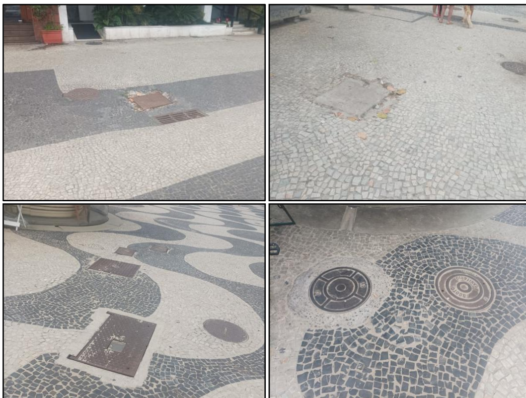
Figura 63 – Tampas de ferro e concreto nas caixas de visita. Avenida Atlântica – Leme.
