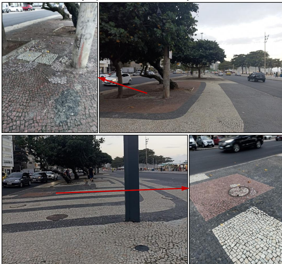
Figura 81 – Manutenção irregular de tampas e caixas de visita interferindo na composição. Avenida Atlântica – Copacabana.
