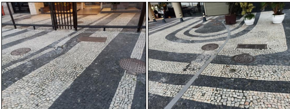
Figura 82 – Frente da garagem de edifícios com rachaduras e desníveis na pavimentação. Avenida Atlântica – Copacabana.
